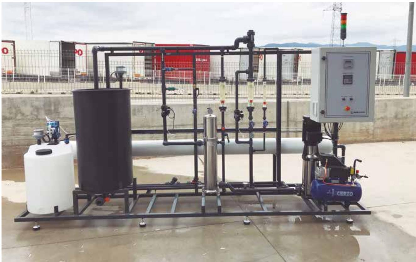
Planta de ósmosis inversa de 60 m<sup>3</sup>/d instalada en Argelia.
